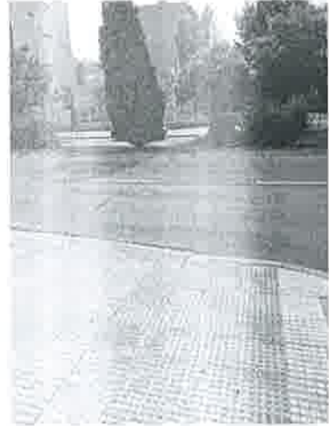
Paso de peatones inexistente calle Grecia con calle Holanda
