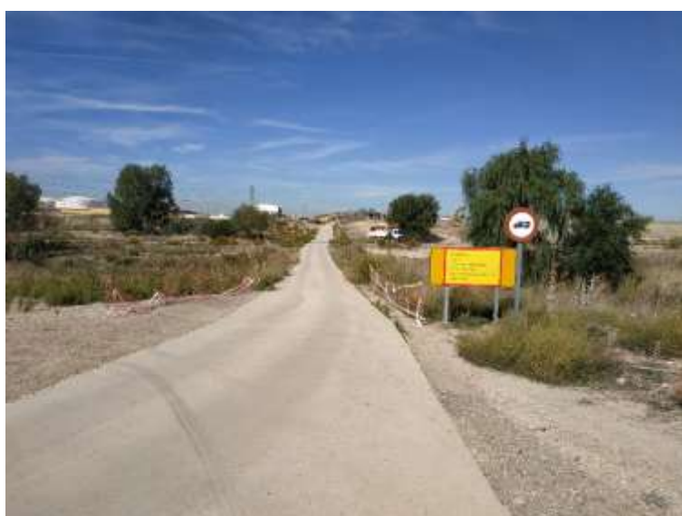
Fotografía 12. Vistas sub-tramo 4 cruce arroyo del Valle.
