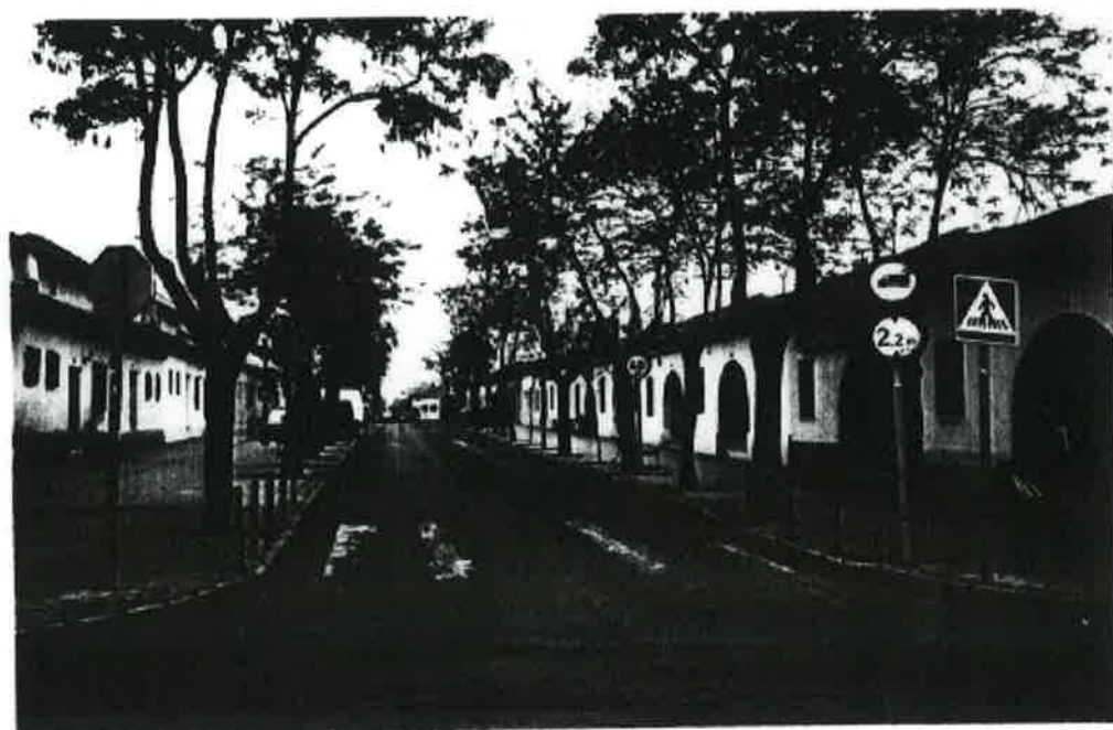
Estado actual C/ Río Miño. (Se aprecian áticos añadidos).
