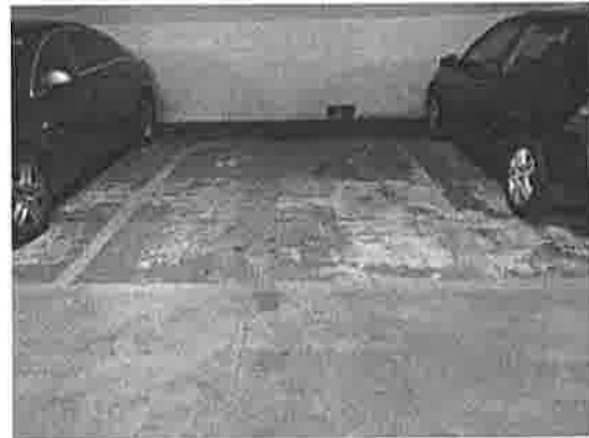
Estado del suelo
