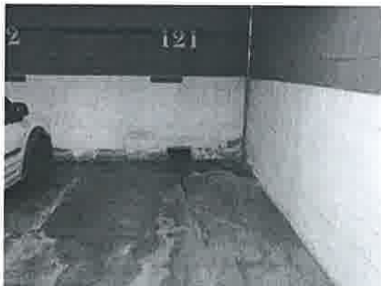
Estado del suelo
