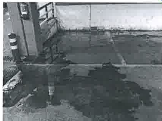
Estado del suelo
