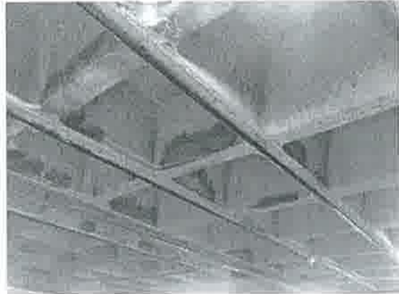
Estado del techo
