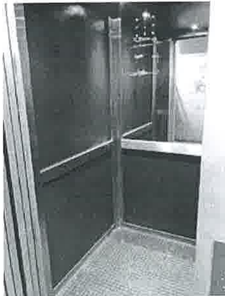
Estado de la cabina del ascensor
