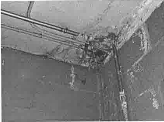
Estado del techo
