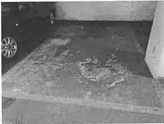
Estado del suelo
