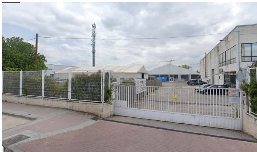
Vista de la antena localizada dentro del ámbito
