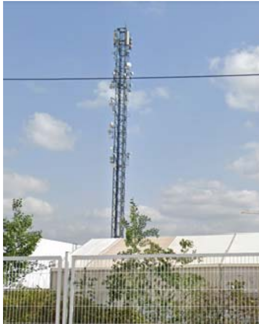
Vista torre de comunicaciones a desmontar
