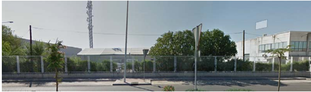
Vista tendido aéreo de comunicaciones
