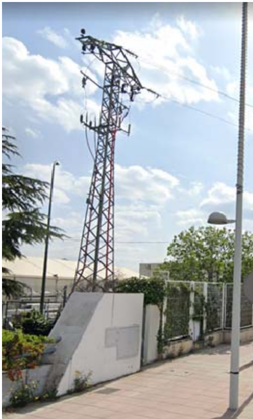
Vista torre de celosía metálica de energía eléctrica a desmontar
