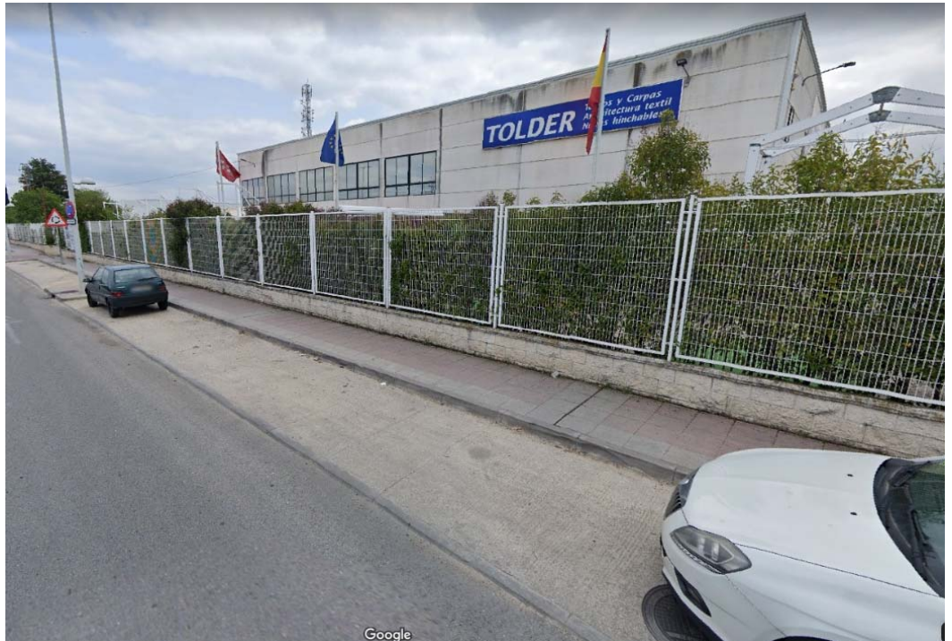
Vista fachada empresa Tolder desde Av de la Constitución
