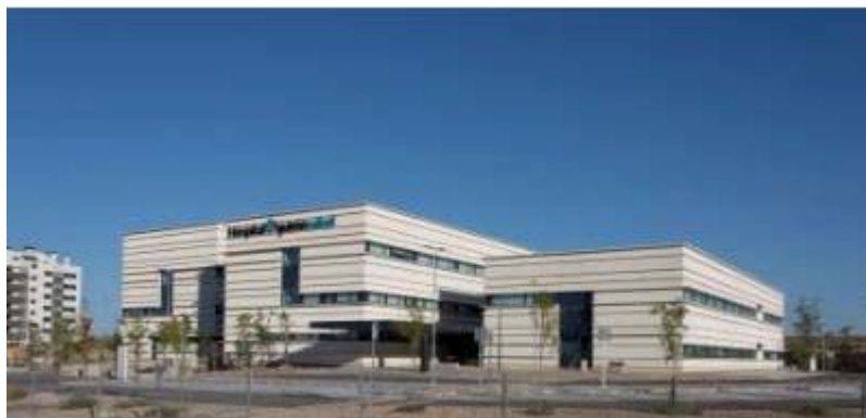
Hospital Quirónsalud Valle del Henares
