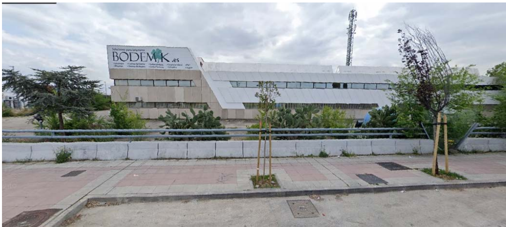
Vista fachada empresa Bodem K Soluciones de Interiores, SL desde Av de la Constitución
