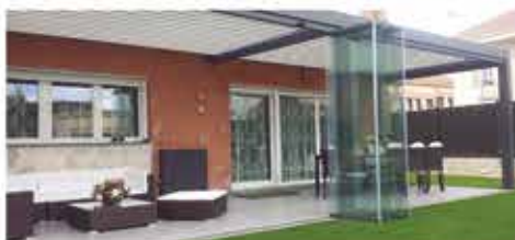
Cerramientos de Terrazas Pacios y Porches
