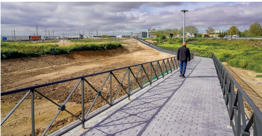
El camino peatonal discurre entre la calle Margarita Salas del Polígono Los Almendros y la calle Atenea del barrio de Fresnos, discuriendo en paralelo a la carretera M-206
