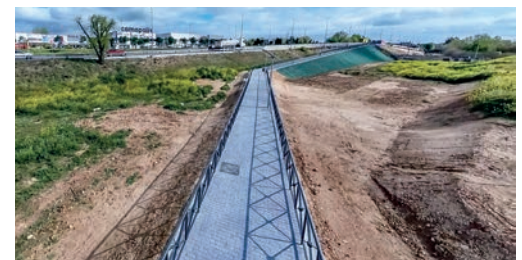
Es un camino pavimentado de 2,5 m de anchura libre y una longitud de 426 m, con vallado perimetral a ambos márgenes
