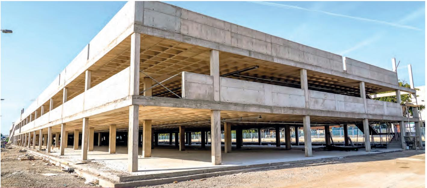
Las obras del nuevo aparcamiento en altura gratuito de 648 plazas que se está construyendo junto a la estación de tren de Torrejón de Ardoz se encuentran muy avanzadas. El estacionamiento contará con una planta baja de 4.274 m<sup>2</sup>, una primera planta de 4.444 m<sup>2</sup> y una segunda planta de 4.444 m<sup>2</sup>. Está previsto que comience a funcionar el próximo mes de noviembre.
