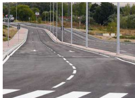
Se ha dotado de carril bici y acera para peatones
