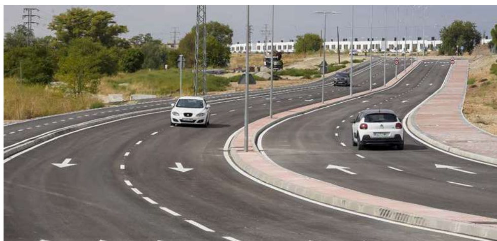
El nuevo vial de 950 metros de longitud cuenta con cuatro carriles de circulación de 3,5 metros cada uno
