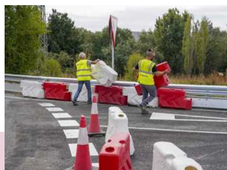
Momento en que se abrió al tráfico el nuevo tramo de la Ronda Sur
