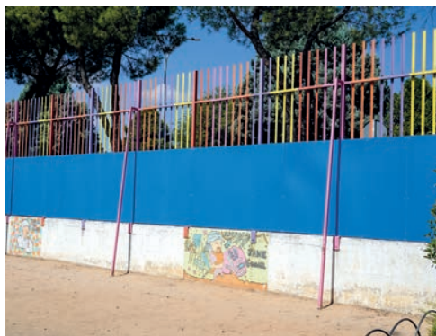
Cerramiento en el vallado exterior del colegio Andrés Segovia
