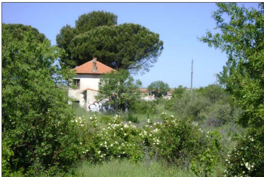
Figura 2.7.d. Detalle de la edificación rural en la parcela nº 10
