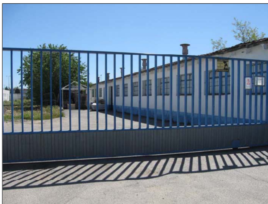
Figura 2.7.h. Detalle del conjunto de edificaciones industriales en la parcela nº 18
