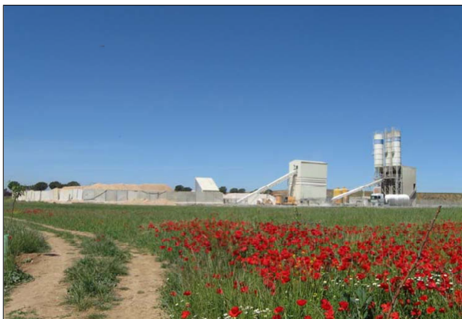
Figura 2.7.p. Detalle de la planta de hormigón y clasificación de áridos
