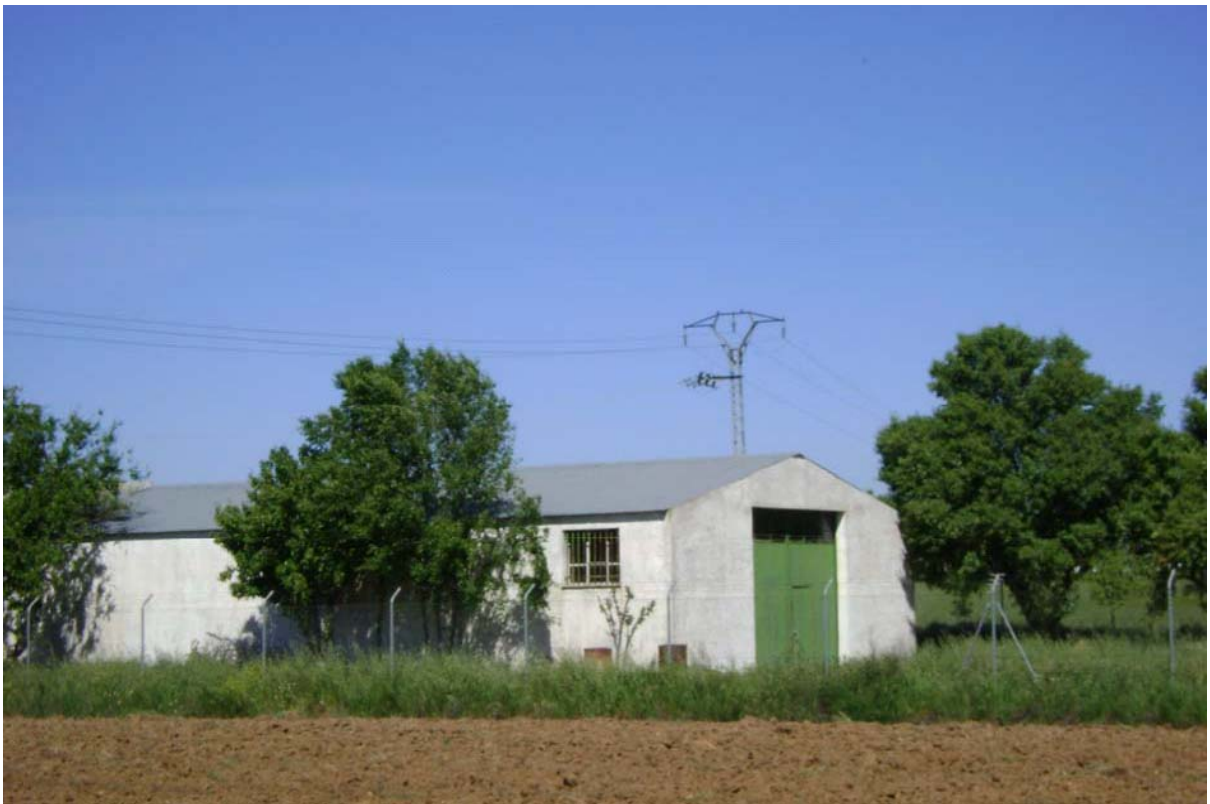
Imagen 6. Vista de una de las pequeñas acometidas eléctricas que da suministro a las edificaciones que se encuentran actualmente dentro del Sector.
