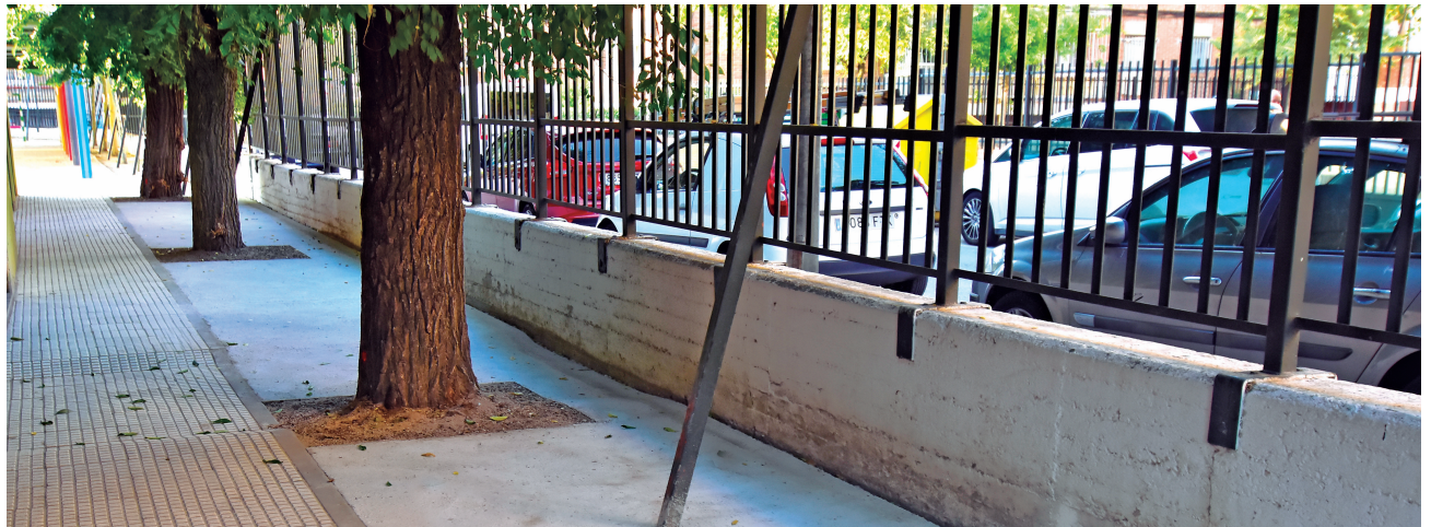
Pavimentación de zonas terrazas
