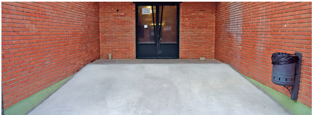
Creación de una rampa en una de las entradas
