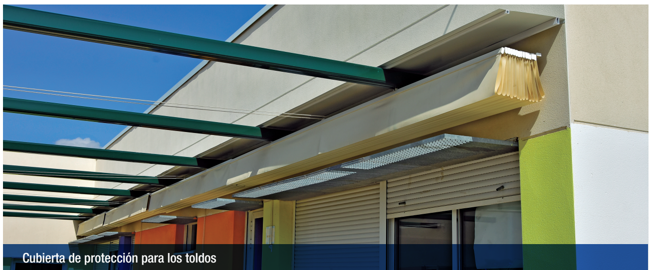
Instalación de cubierta de lona
