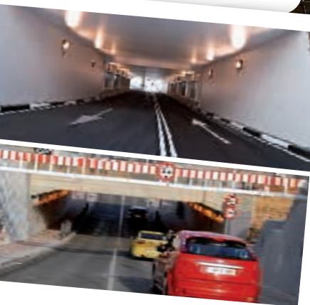
Paso de Loeches Paso de Zapatería
