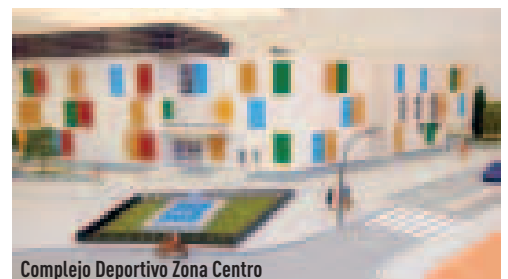
Complejo Deportivo Zona Centro
