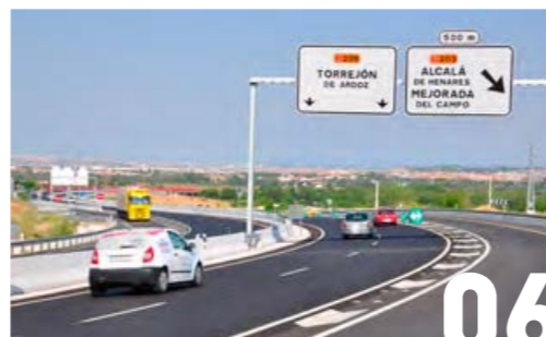
06 Entra en funcionamiento la nueva carretera M206 entre Torrejón y Loeches
