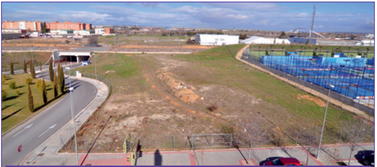
➤ Terrenos sobre los que ya se ha iniciado la construcción de la segunda estación de Torrejón, en Soto Henares junto al hospital
