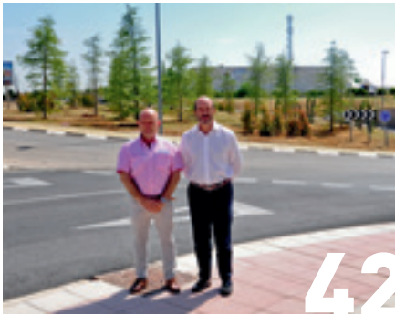
Reformada la gran Glorieta en la Avda. de la Constitución con P.º de la Democracia
