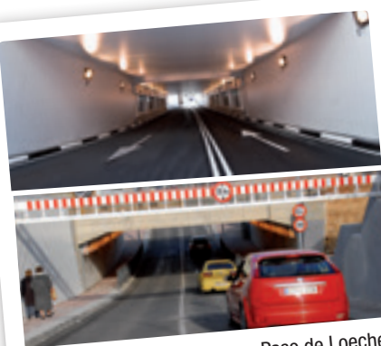
Paso de Loeches Paso de Zapatería
