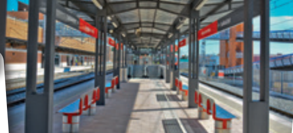
Reformada la actual estación de tren de Plaza de España
