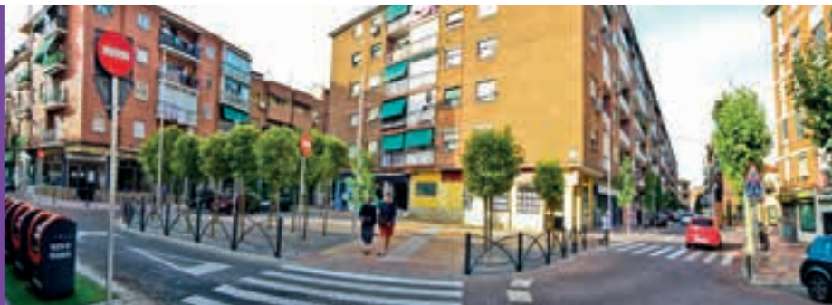
Con la reforma se han eliminado las barreras arquitectónicas
