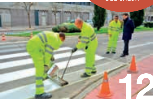
Finalizados los trabajos de pintura y señalización horizontal para el tráfico en 37 calles
