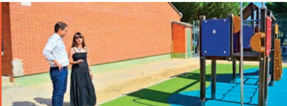
El alcalde comprobó las obras en el colegio Joaquín Blume junto a su directora
