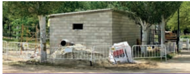
Construcción de nuevos aseos públicos en la zona del lago
