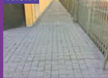
Reparación de la acera perimetral con pavimento impreso (210 m<sup>2</sup> y 70 metros lineales).
