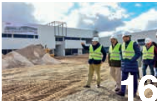
16 Avanzas las obras de construcción del futuro Parque Comercial On Plaza
