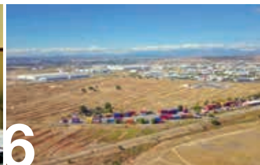
Arrancan las obras de construcción del nuevo Polígono Industrial Los Almendros
