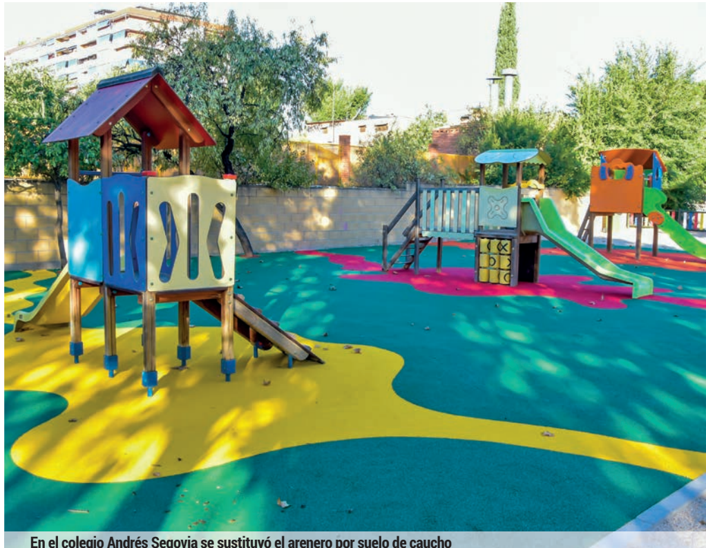
En el colegio Andrés Segovia se sustituyó el arenero por suelo de caucho
