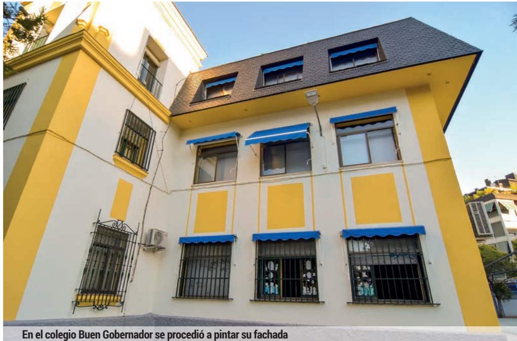
En el colegio Buen Gobernador se procedió a pintar su fachada
