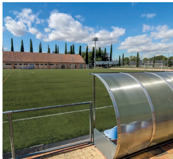
Se han reparado los banquillos del Complejo Deportivo J.A. Samaranch
