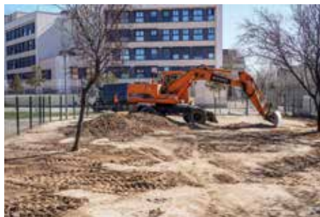
Renovación de 5.680 metros cúbicos de arena
