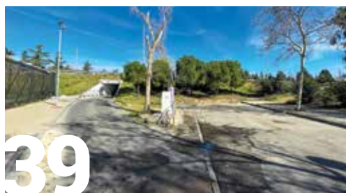
39 Torrejón va a contar con 3 nuevos pasos subterráneos para mejorar la movilidad de peatones y vehículos en los barrios de Fresnos, Cañada y Juncal
