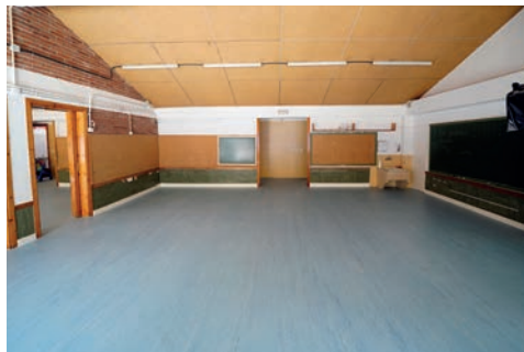
Renovación de suelo en aulas
