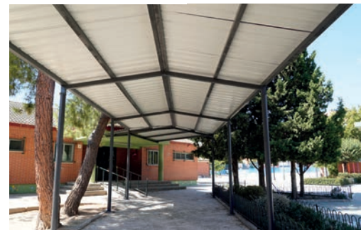
Instalación de pérgolas en los accesos de los colegios
