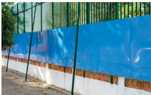
Instalación de valla lacada
