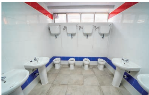
Renovación de aseos
