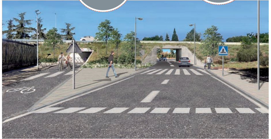
En esta infografía se recrea el nuevo paso de vehículos contará con dos carriles de 3 metros como prolongación de la Calle Atenea, mediante dos cajones empujados desde ambos lados de la M206
