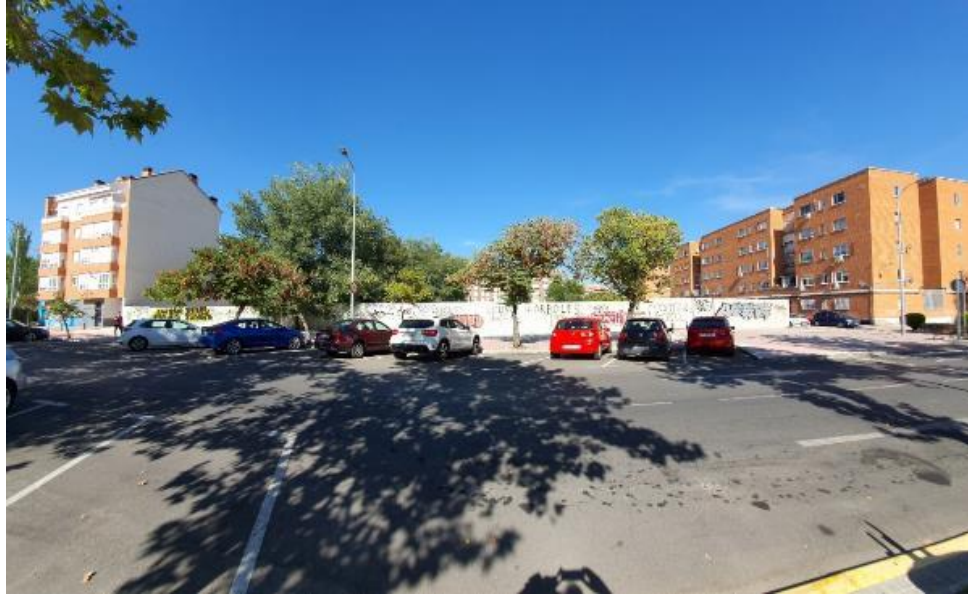
Fachada hacia la Calle del Río.
