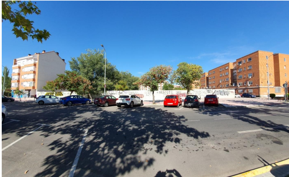
Fachada hacia la Calle del Río. El edificio a la izquierda de la imagen tiene cinco plantas sobre rasante y es colindante con el solar de uso residencial de la misma propiedad, que se sitúa entre el edificio y el terreno objeto de la modificación. A la derecha los bloques de cinco alturas situados en la calle Arganda, frente al terreno objeto de la modificación.
