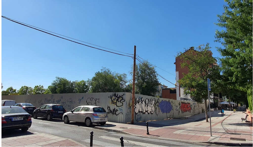
Vista del cerramiento de los terrenos desde la esquina entre Carretera de Loeches y Calle Arganda.
