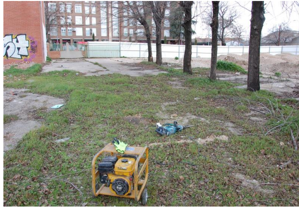
Martillo rompedor y generador eléctrico utilizado en la toma de muestras
